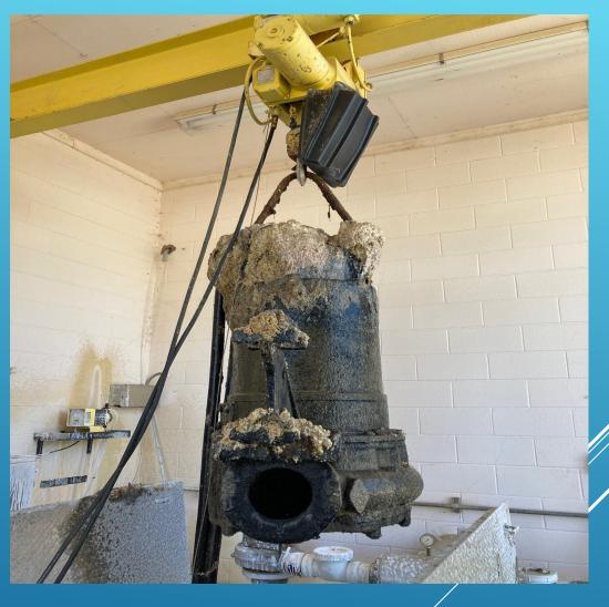
UN-WIRING AND PULL OF PUMP 2 / HUCKLEBERRY LIFT STATION
